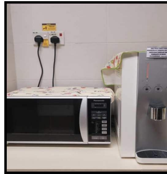
Menutup punca elektrik bagi mesin penapis air di pantri pejabat sebelum pejabat ditutup
