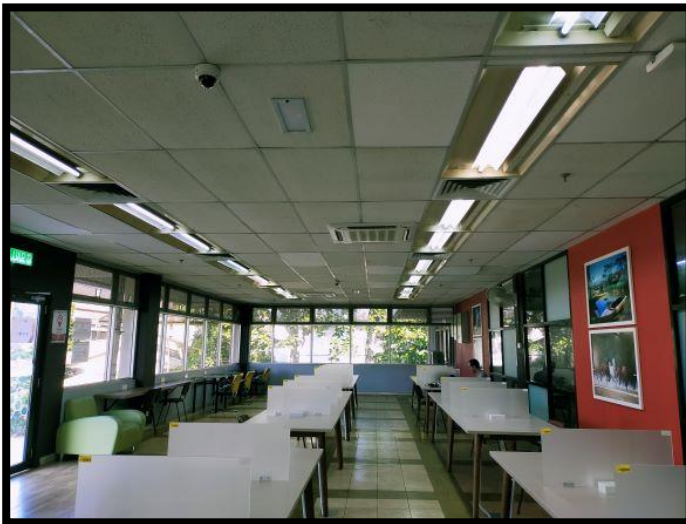
Menggunakan split air cond di Bilik 24 Jam, Bangunan PSZ
