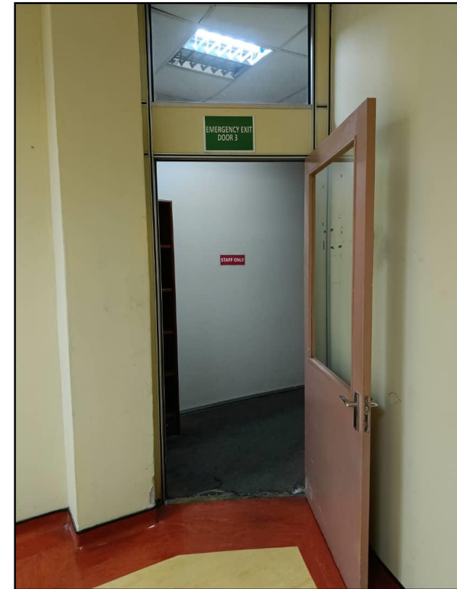
LALUAN KECEMASAN DI PINTU KELUAR/MASUK LALUAN STAF
